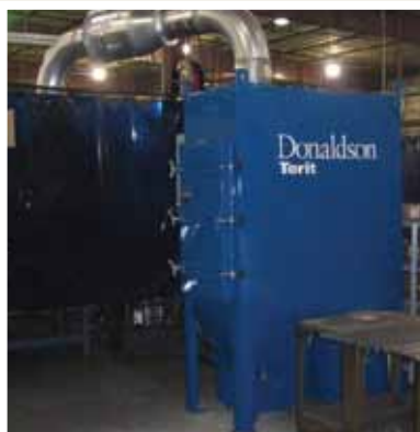
TG4 En soldadura
